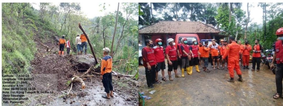
Gambar 2.21. Penanganan Tanah Longsor dan Briefing Tim SAR Penanganan Bencana
